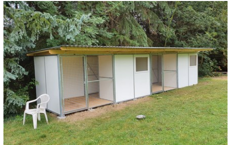
DER DOPPELZWINGER NACH DEM AUFBAU, NOCH OHNE SCHLEUSSEN.
