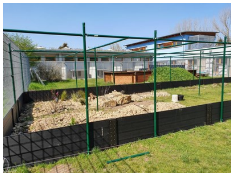
DIE NEUE SCHILDKRÖTENANLAGE MITTEN IN DER BAUPHASE.
