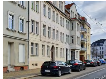
BLICK AUF DIE NEUE GESCHÄFTSSTELLE WOLFENER STRASSE
